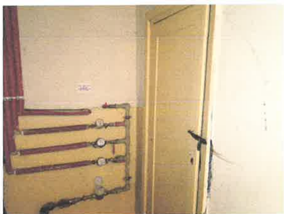
Drzwi wejściowe do komórki przynależnej pod schodami na parterze
