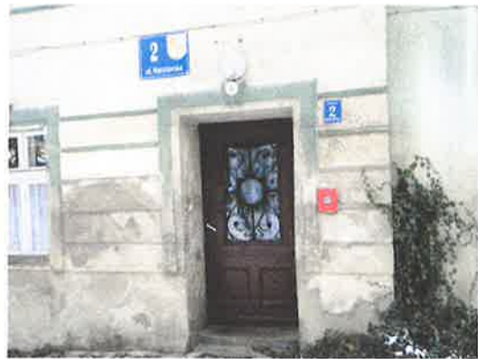
Wejście do budynku
